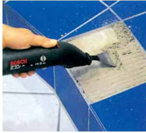
Odstraňovanie podkladu nám pôjde ľahšie elektrickou škrabkou alebo opäť môžeme použiť sekáč a kladivo.
